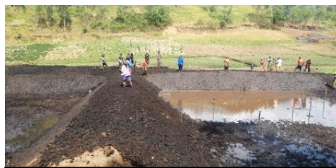
Nouveaux étangs piscicoles aménagés
