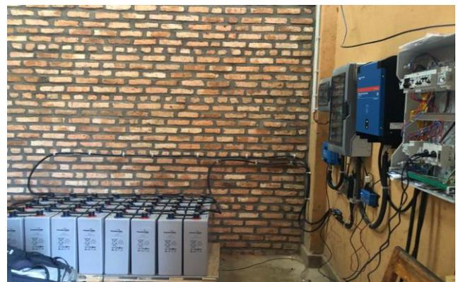
*Installation des panneaux solaire et raccordement des batteries*
